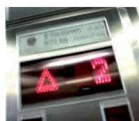
6. La central de incendios toma el control de los ascensores y evita que éstos se detengan en las plantas afectadas o desplaza el ascensor a una posición predefinida.
